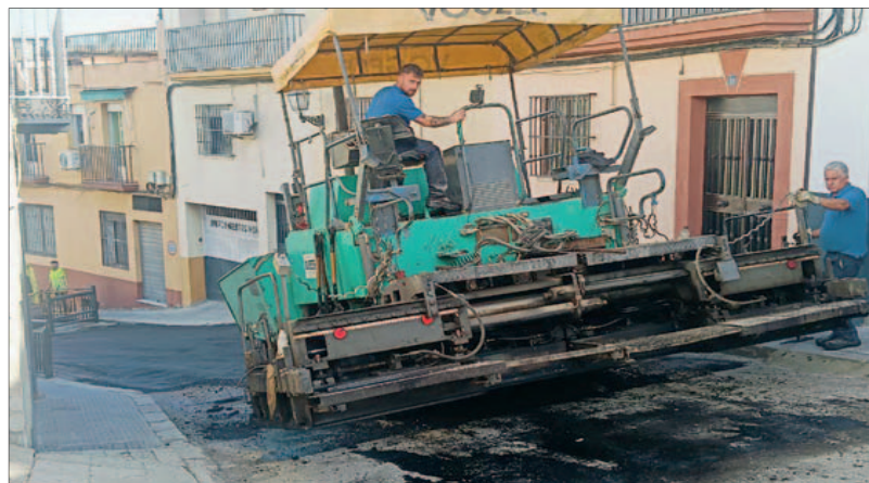
INTERVENCIÓN. Dos operarios trabajan con una máquina de asfalto en la calle Tiro Nacional.
