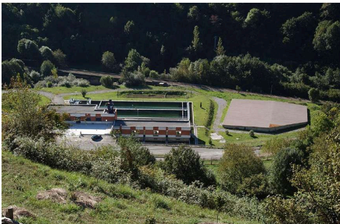
La depuradora de agua de Levinco. / LNE
